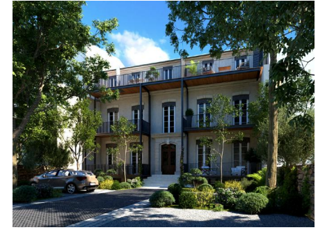
IMMEUBLE PIERRE SÉMARD
