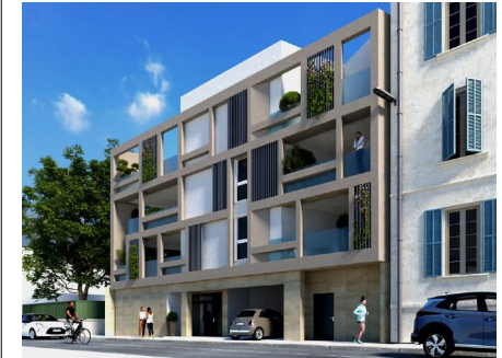
IMMEUBLE NOTRE DAME
